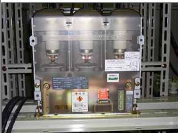
真空電磁接触器(VMC)
