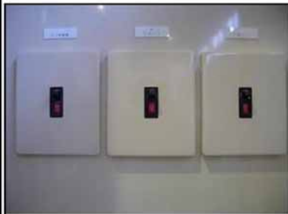
配線用遮断器(MCCB):埋め込み型 表面
