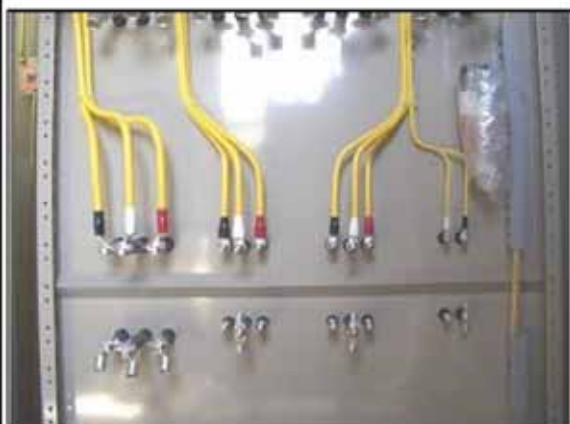
配線用遮断器(MCCB):埋め込み型 裏面
