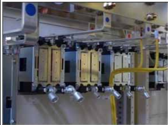
配線用遮断器(MCCB):埋め込み型 裏面
