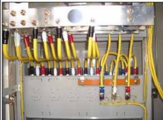
配線用遮断器(MCCB):裏面型 裏面
