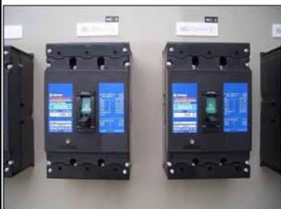
配線用遮断器(MCCB):埋め込み型 表面
