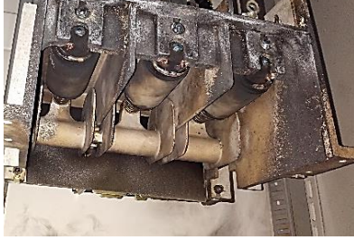
[ 焼損した VCB ]
