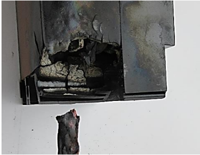
[ 焼損、溶断した38sqケーブル ]
