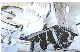
[直撃雷で短絡焼損]
