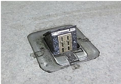
[フロア面に設置されたコンセント]
