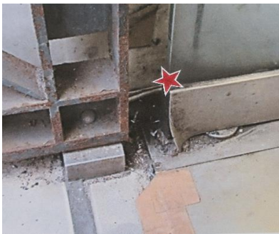
[ ドア金属部に圧迫されたコード ]
