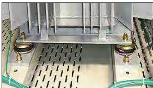
変圧器に防振ゴム取付
