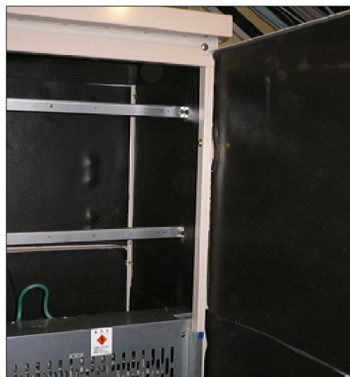
扉へ防音材を貼付け
