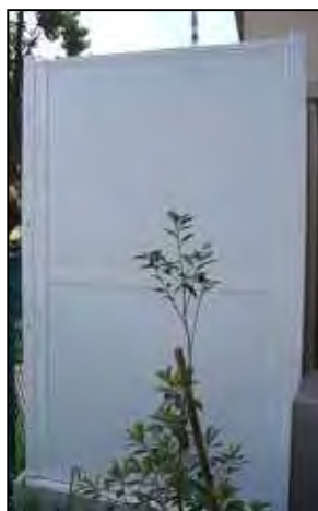
隣への隣接面に防音壁取付
