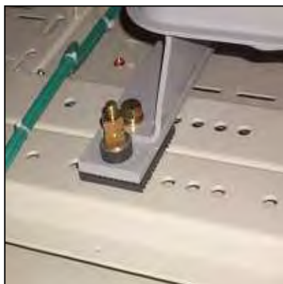
変圧器に防振パッド取付
